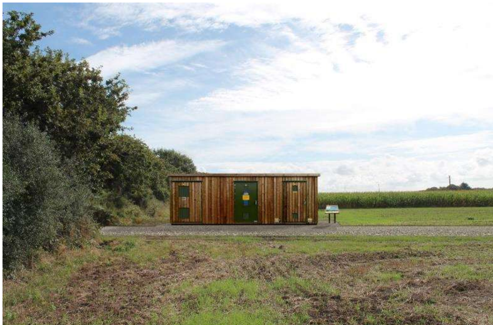
Figure 161 : Habillage bois du poste de livraison
